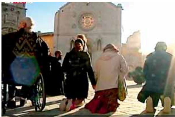
Persone che pregano davanti alla facciata della Basilica di san Benedetto a Norcia, danneggiata dal terremoto.
